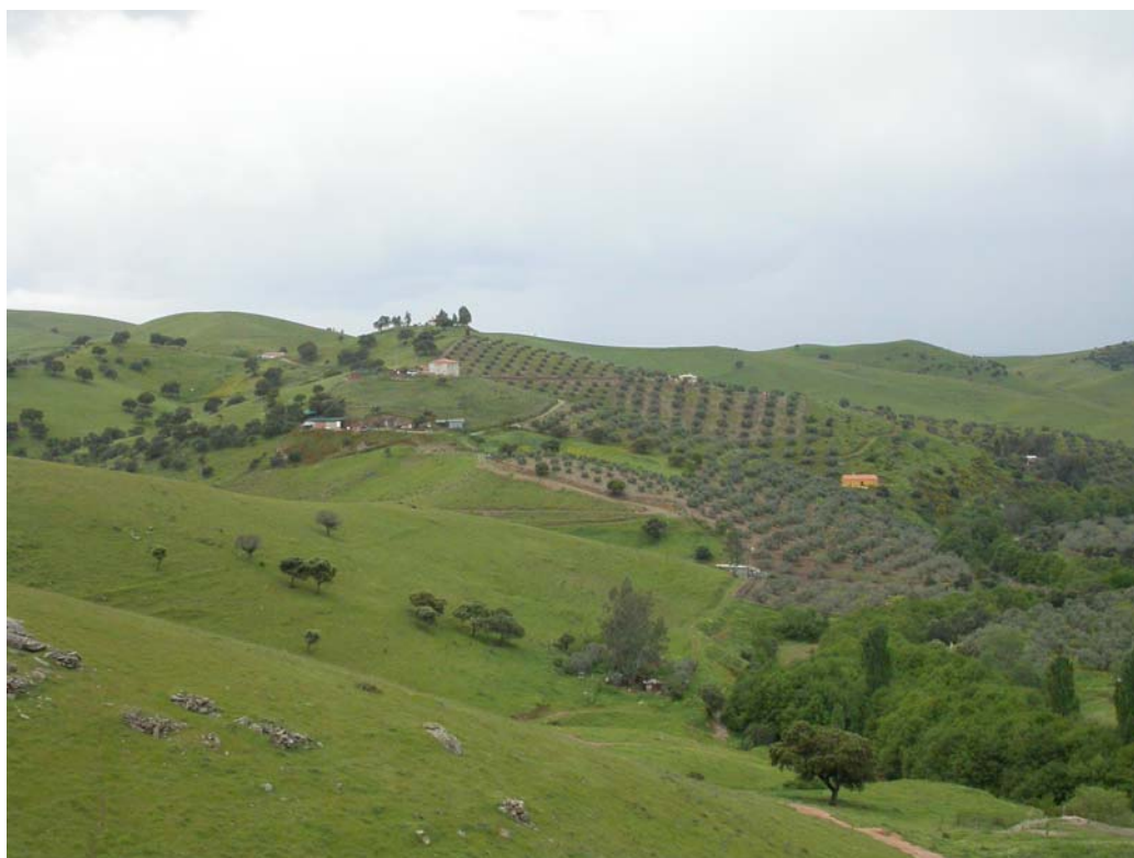
Figura. Edificaciones ilegales y cultivos de olivar sobre suelo protegido.
